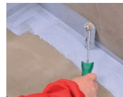
4 / Naniesieme hydroizoláciu na zvýšené exponované miesta.
