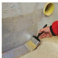
2 / Napenetrujeme podklad a zjednotíme nasiakavosť.
