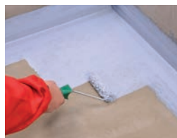
7 / Celoplošne naniesieme prvú vrstvu.
