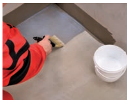
2 / Napenetrujeme podklad a zjednotíme nasiakavosť.
