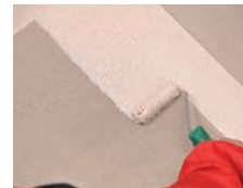
8 / Nanesieme druhú vrstvu hydroizolácie kolmo na prvú vrstvu.
