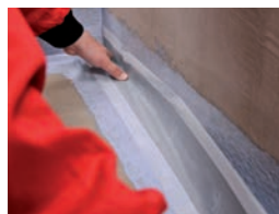
5 / Odmeriame požadovanú dĺžku pásu a vložíme do hydroizolačného náteru.
