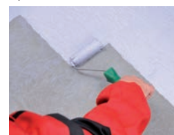
8 / Naniesieme druhú vrstvu hydroizolácie kolmo na prvú vrstvu.
