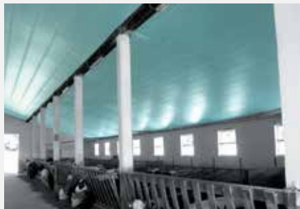
Viditeľná tepelná izolácia FIBRANxps MAESTRO chráni maštale a hospodárske budovy v lete pred prehrievaním a v zime pred ochladzovaním.
