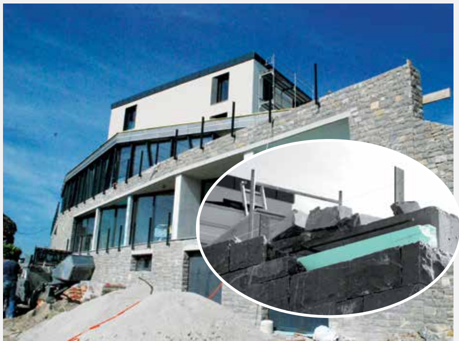
Kamenná fasáda budovy hotela, tepelne izolovaná FIBRANxps ETICS BT , nosnou izoláciou, na ktorej je špeciálnym spôsobom nalepený prírodný kameň.
