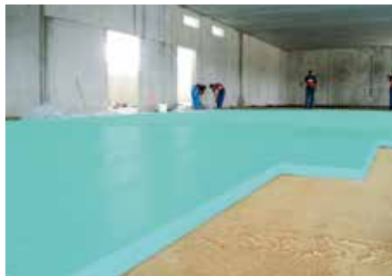
Tepelná izolácia podlahy v sklade s FIBRANxps 300-L.
