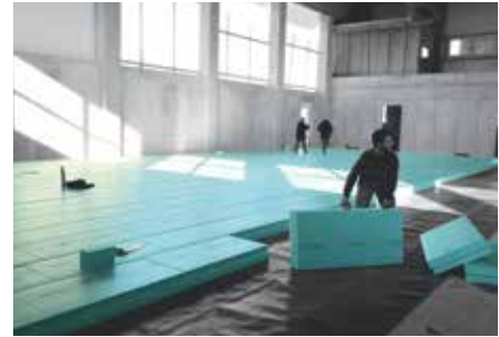
Inštalácia tepelnej izolácie FIBRANxps 500-L pod podlahovú dosku multifunkčnej budovy.
