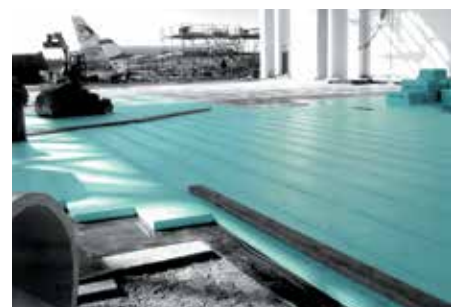
Tepelná ochrana podlahy v hangári s FIBRANxps 700-L.
