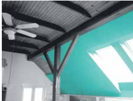
Realizácia vnútornej tepelnej izolácie s FIBRANxps ETICS , ktorú na povrchu chránime vrstvami tenkovrstvovej fasády a omietkou.
