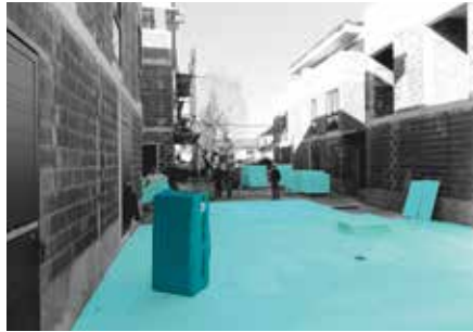
Tepelná ochrana pochôdznej platformy podpivničených bytových jednotiek.
