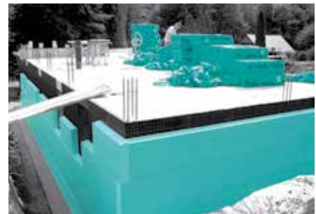
Pevná, prakticky nenasiakavá izolácia FIBRANxps 300-L je mechanická ochrana hydroizolácie a trvácna tepelná ochrana podzemnej časti budovy aj v prípade vysokej hladiny podzemnej vody.
