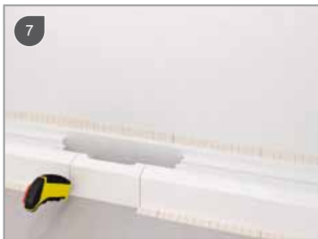
Vyřízněte z polystyrenového bloku kus potřebný pro připojení nátrubek a zemnicí šroub
