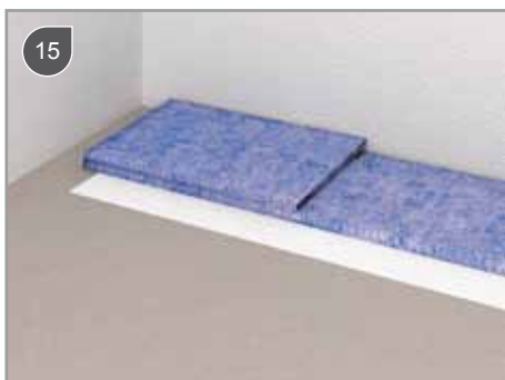
Potěr by měl být proveden až k 2cm široké přední hraně polystyrenového bloku
