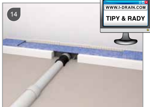
Aplikujte potěr se spádem 1% - 2% ke žlábků
