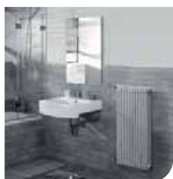
Dříve: starý radiátor
